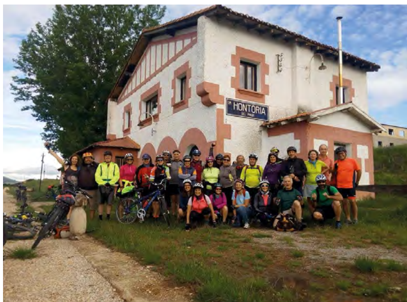
Estación Hontoria del Pinar (Burgos) en el Camino Natural Vía Verde del Ferrocarril Santander-Mediterráneo.
