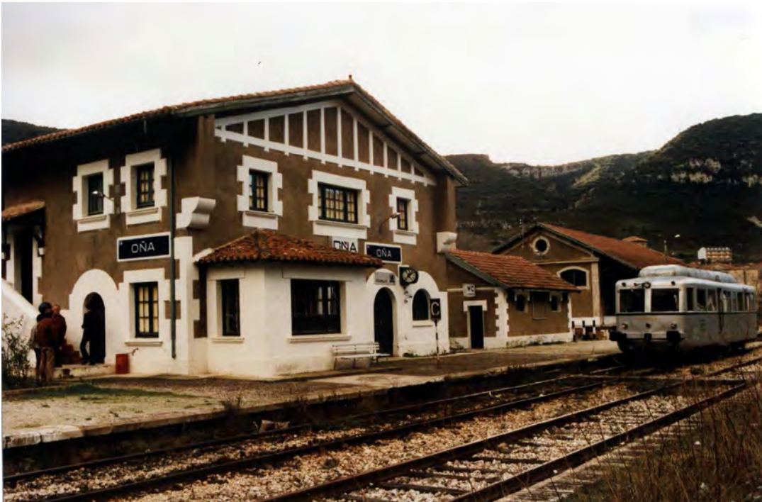
Estación de Oña en Burgos. Camino Natural Vía Verde del Ferrocarril Santander Mediterráneo.
