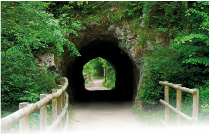
Túneles ferroviarios, viajes en el tiempo.
