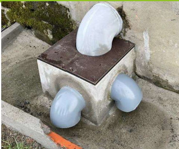
Arqueta registrable colector final con filtro para partículas
